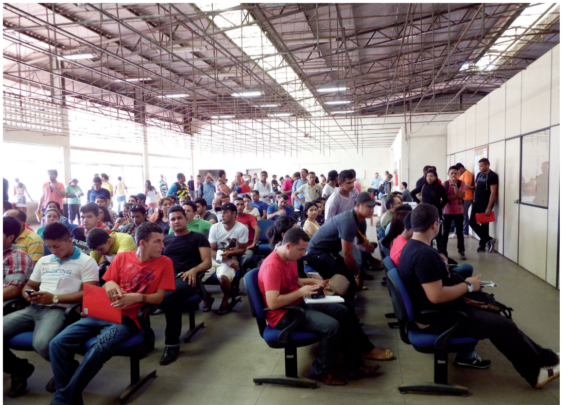
Local de atendimento ao público possui pouca ventilação e não tem forro. O telhado de zinco possibilita um ambiente calorento
